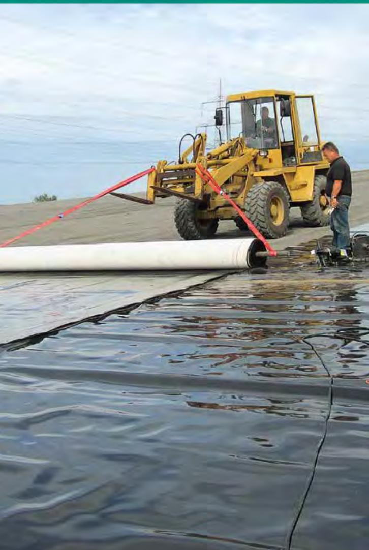
Für mineralische Tondichtungen sind Schichtdicken von bis zu 100 cm nötig. BENTOMAT erzielt eine mindestens vergleichbare Dichtwirkung bereits bei einer Dicke von nur ca. 1 cm.
