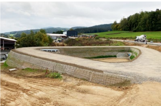
Bau von Rückhaltebecken
