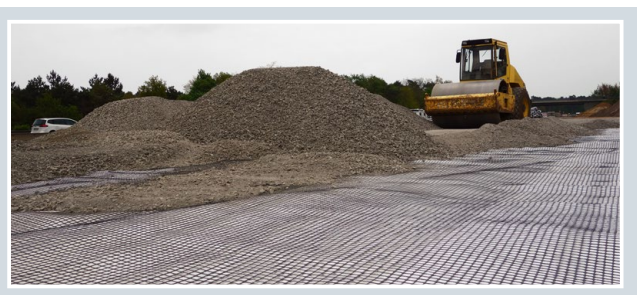
Abbildung 5: Überschüttung des Geogitters
