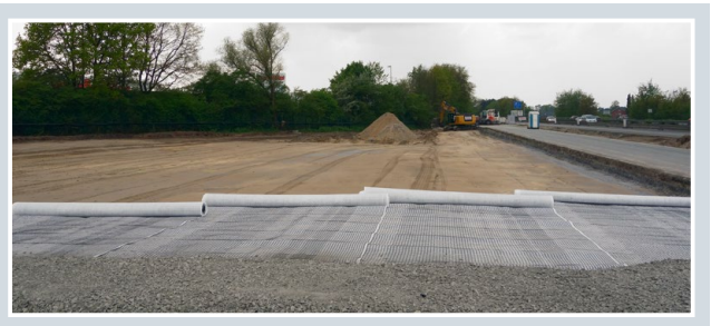
Abbildung 3: Schnelle Verlegung des BEGRID TGV
