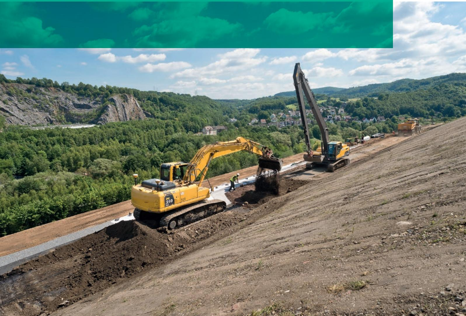
Die Produktwelt der Geobaustoffe umfasst eine Vielzahl innovativer Kunststoffprodukte für das Bauwesen. Je nach Anwendungsgebiet werden Geobaustoffe für die Funktionen Trennen, Filtern, Schützen, Bewehren, Dränen, Erosionsschutz, Verpacken und Dichten eingesetzt. Manche Produkttypen sind auch in der Lage, mehrere dieser Funktionen gleichzeitig zu übernehmen.
