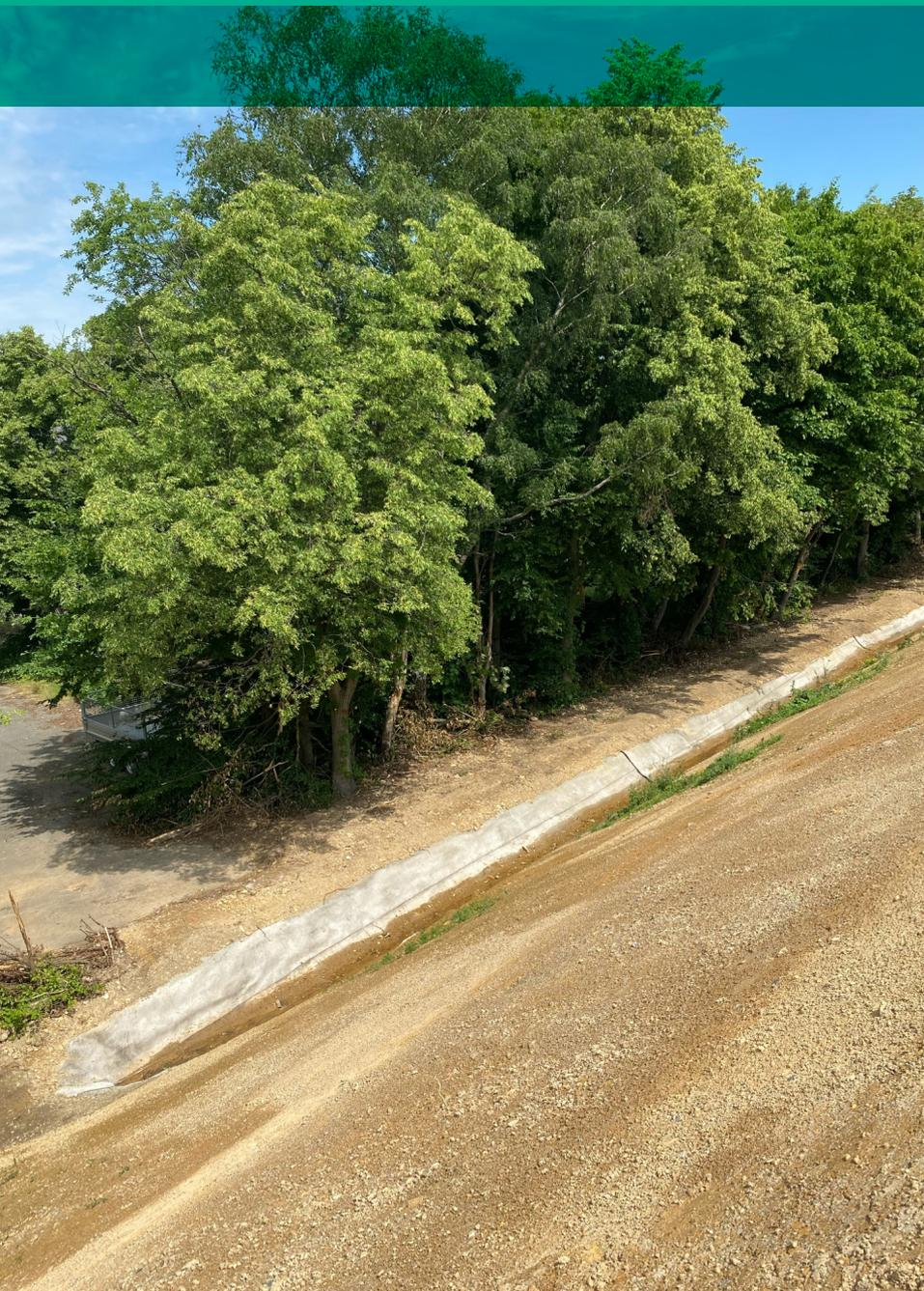
CONCRETE CANVAS Betonmatten ermöglichen es, Ressourcen effizienter zu nutzen, den CO<sub>2</sub>-Ausstoß in der Baubranche zu senken und Bauzeiten zu verringern.
