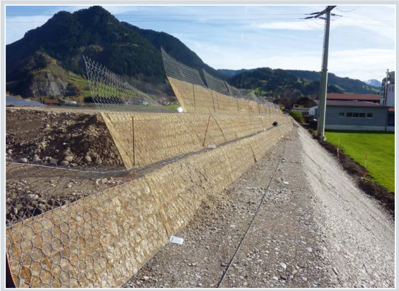
Abbildung 5: Südseite mit anstehendem Damm
