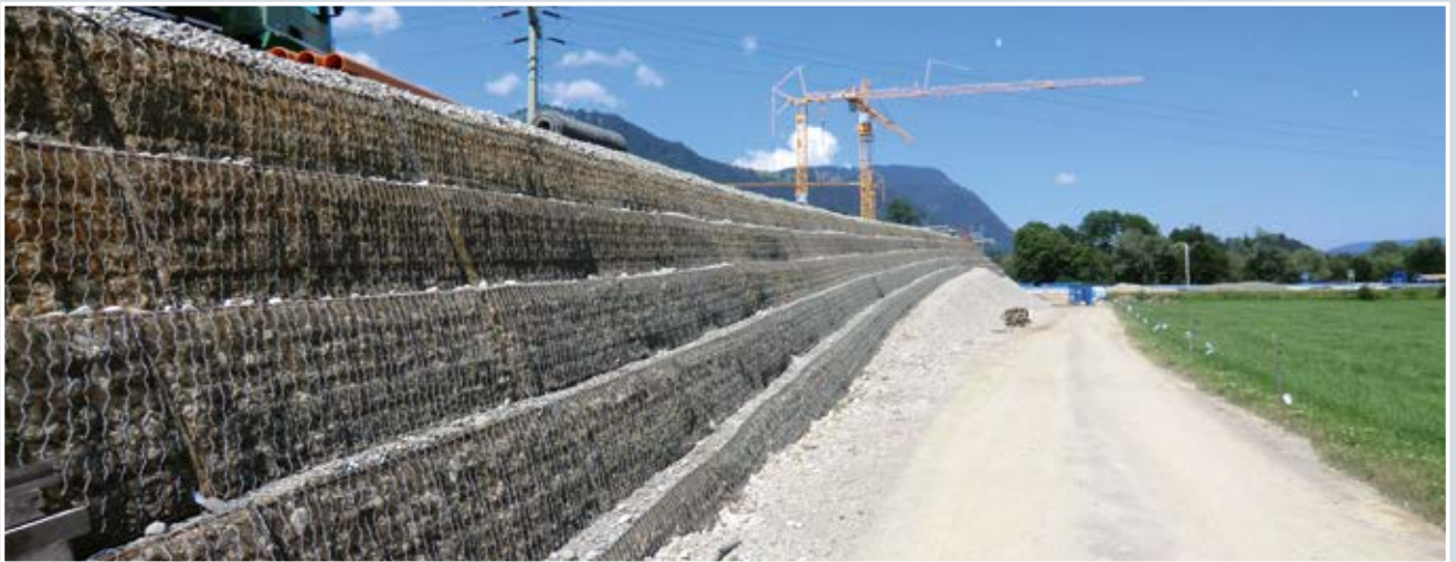
Abbildung 12: Mehrlagiger Aufbau des Steilböschungssystems mit Bermen
