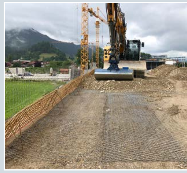
Abbildung 7: Lagenweise Verfüllung der Elemente
