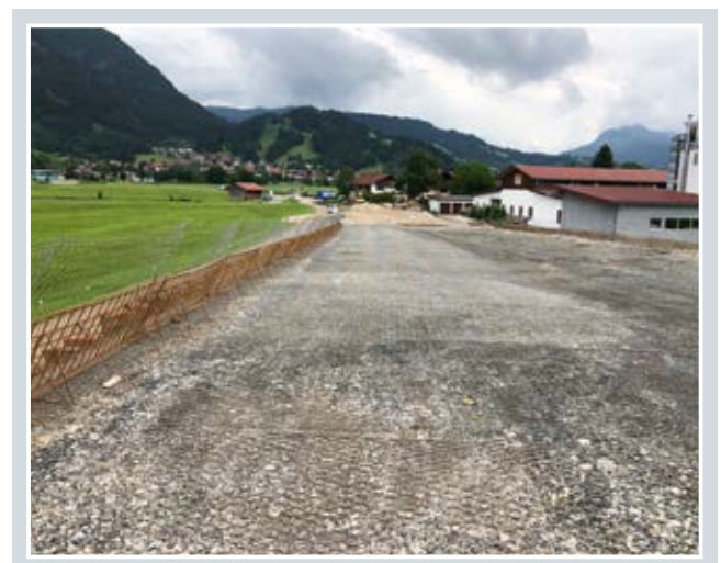
Abbildung 4: Erste Lage GREEN TERRAMESH
