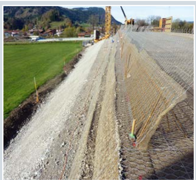
Abbildung 6: Terrassenförmige Anordnung der Bewehrungslagen
