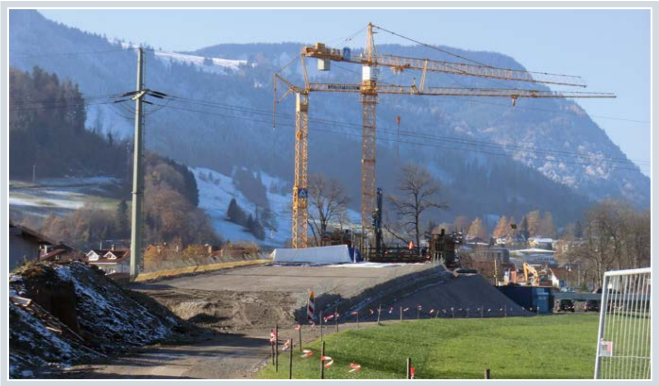
Abbildung 10: Damm zum Brückenbauwerk von Osten
