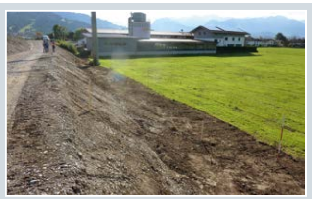
Abbildung 2: Freigelegter Damm zu Baubeginn
