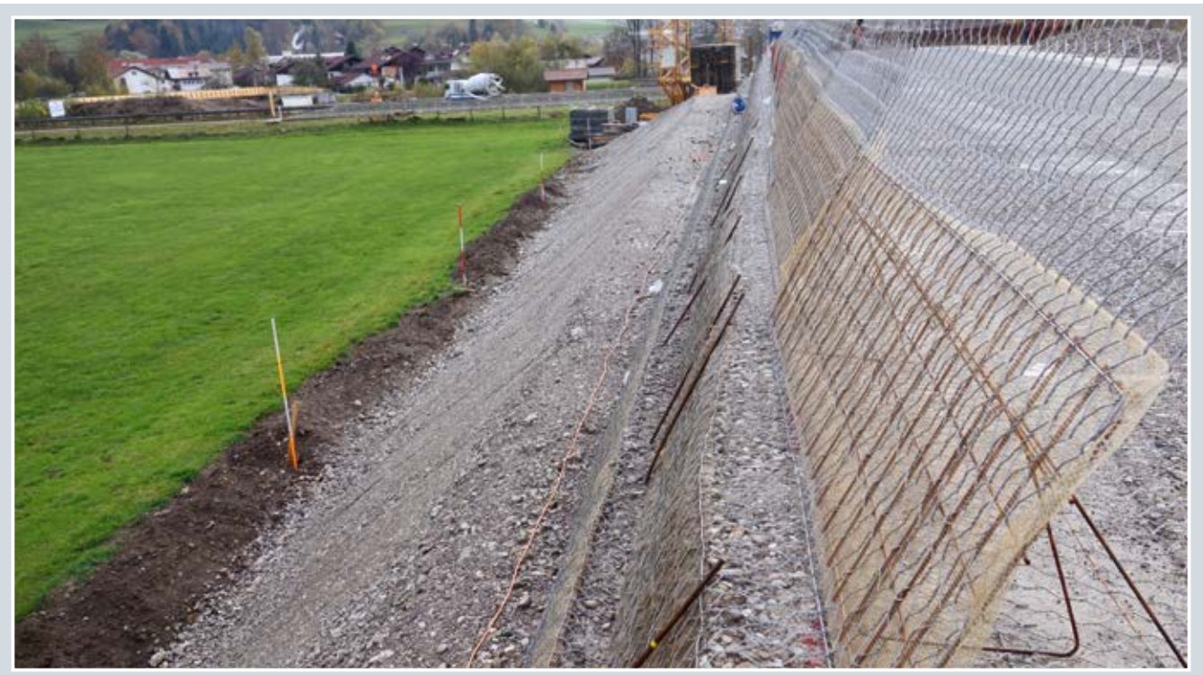
Abbildung 9: Anschüttung der untersten Lage zur Einbindung in das anstehende Gelände
