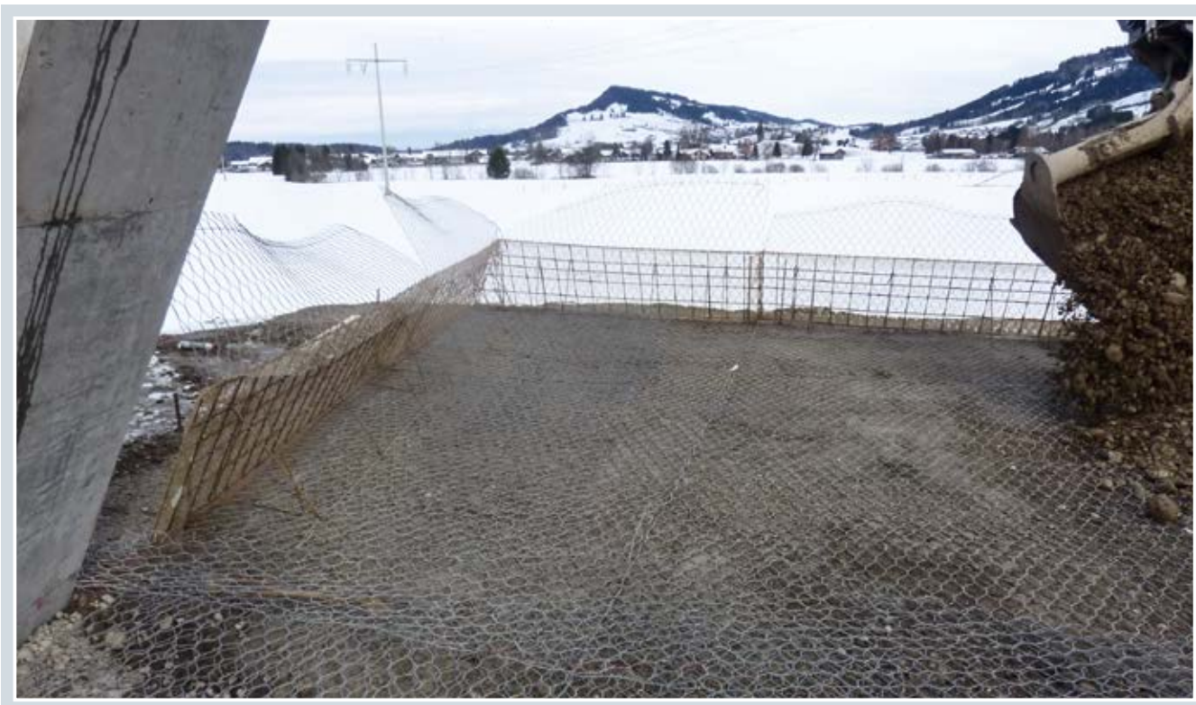
Abbildung 11: Einbau der bewehrten Erde im Bereich der Brückenwiderlager
