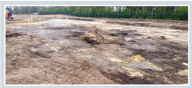
Abbildung 2: Inhomogene Verhältnisse des Erdplanums
