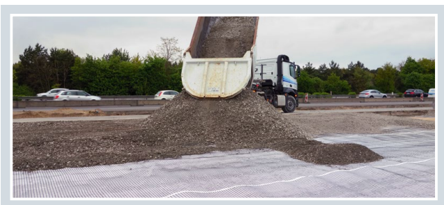
Abbildung 4: Anlieferung Tragschichtmaterial
