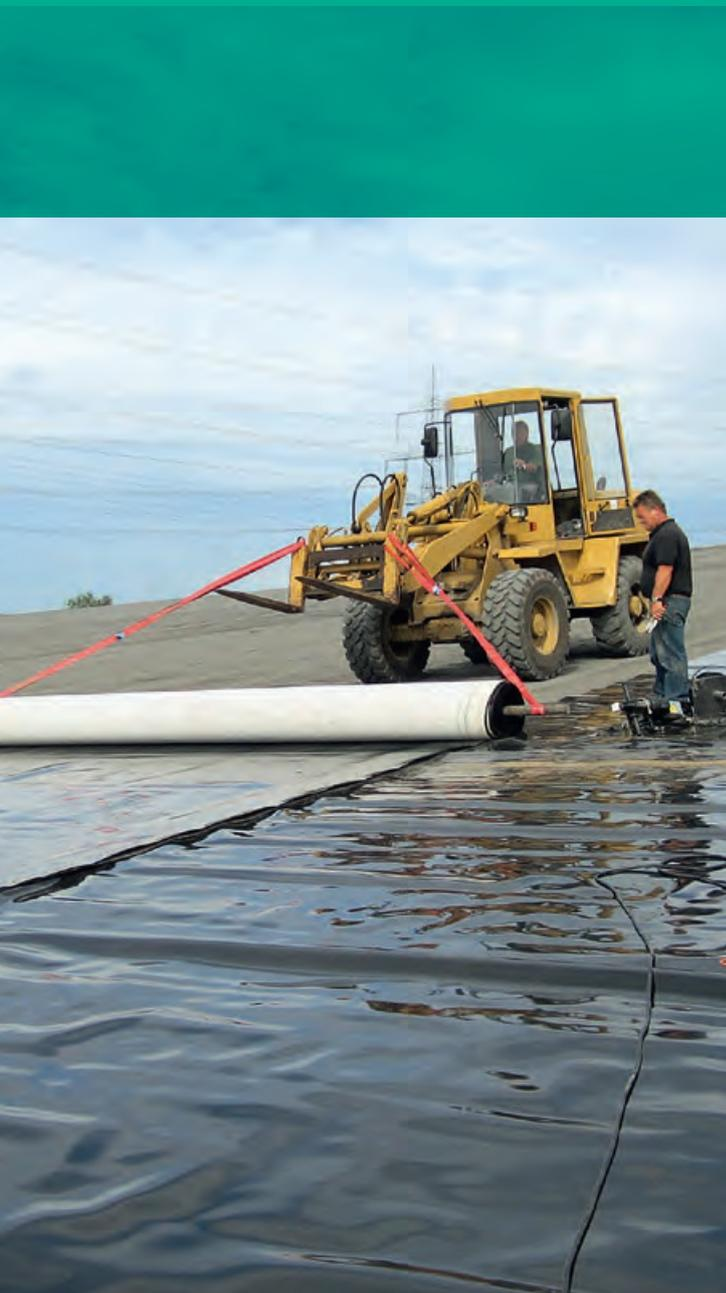
Für mineralische Tondichtungen sind Schichtdicken von bis zu 100 cm nötig. BENTOMAT erzielt eine mindestens vergleichbare Dichtwirkung bereits bei einer Dicke von nur ca. 1 cm.
